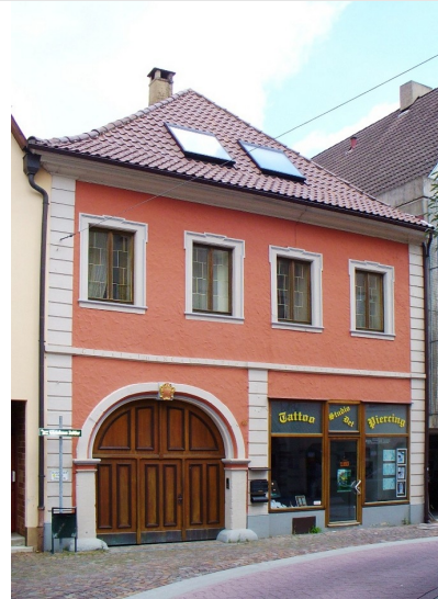
Auch das zurückhaltende Bürgerhaus aus den 1730-er Jahren in der Mühlwehrstraße 18 ist eines von Franz Joseph Roths Bauwerken in Mergentheim
