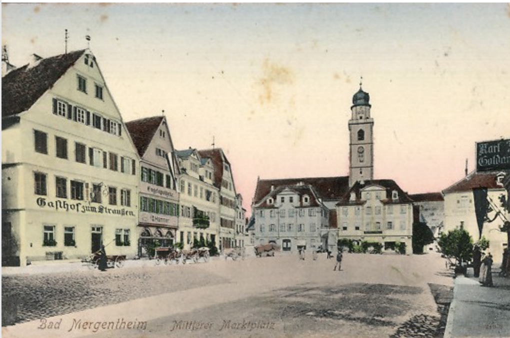
Gasthof zum Straußen mit ehem. verputzter Fassade, heute Volksbank mit Fachwerk
